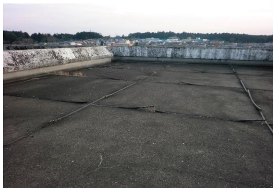
写真-11：屋上防水層の劣化
