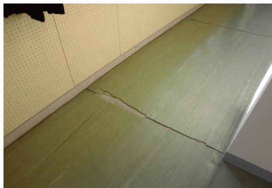
写真-12：内部床 破損
