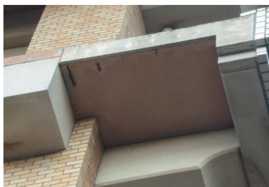
写真-10：軒裏 鉄筋露出
