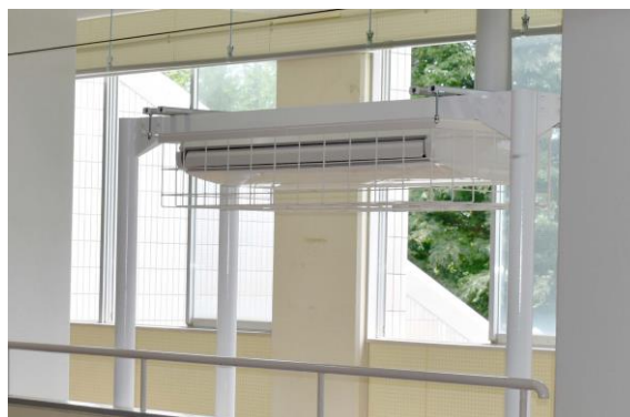
写真-2：屋内運動場への空調機設置
