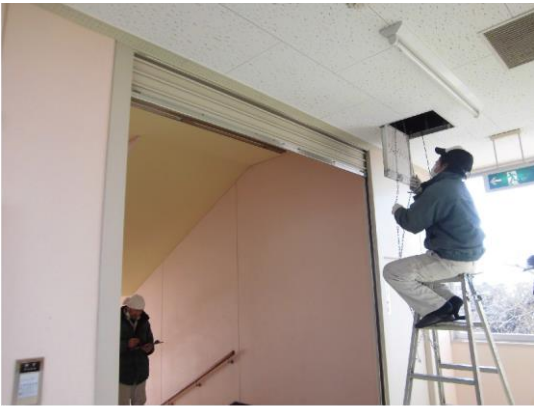
写真-8：防火設備作動調査
