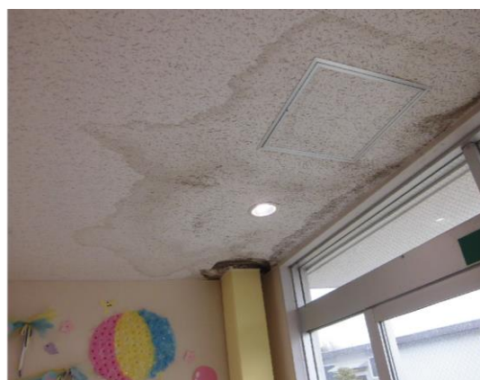
写真-16：漏水による天井腐食
