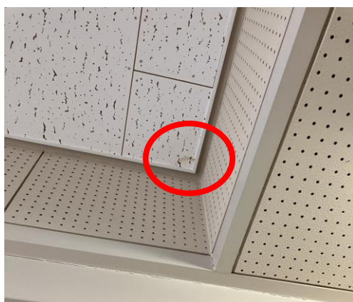
写真-15：漏水による天井のしみ
