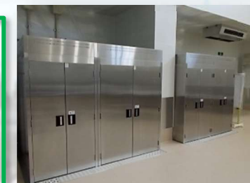
⑭ カートン消毒保管機
