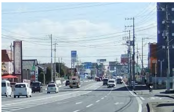
■国道409号（富里インターチェンジ周辺）
