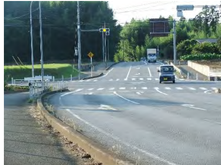
国道409号と市道01-008号線との交差点
