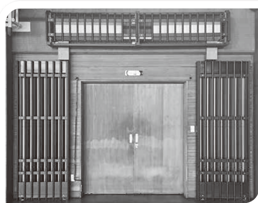
富里社会体育館に設置された 最先端の輻射パネル併用型エアコンシステム
