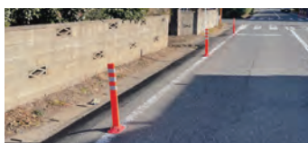
▲車線分離標(オレンジ色のラバーポール)
