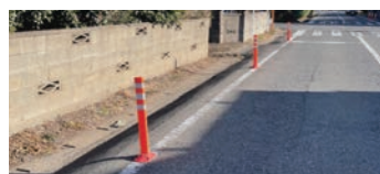
▲車線分離標(オレンジ色のラバーポール)
