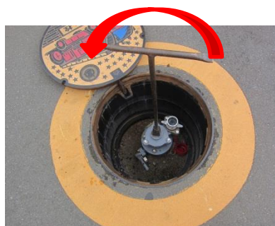
【スピンドルドライバー取付け】
