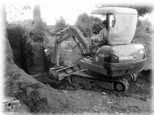
重機を使用した発掘調査
