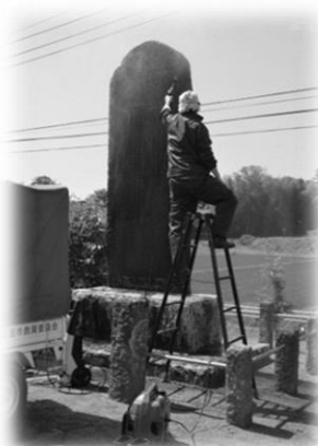
高圧洗浄機による石碑の洗浄
