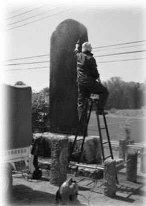
高圧洗浄機による石碑の洗浄
