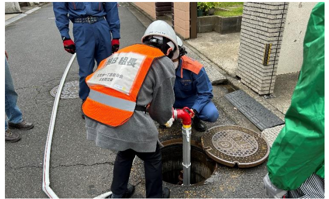
消火栓の使い方の訓練
