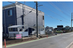
▲グリーンベルト、ポール設置
