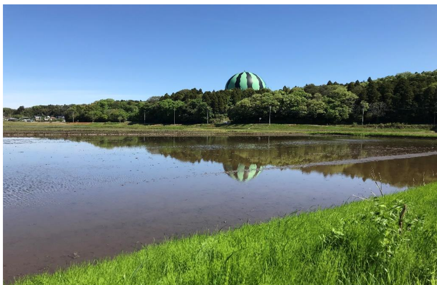
すいか形ガスタンク
