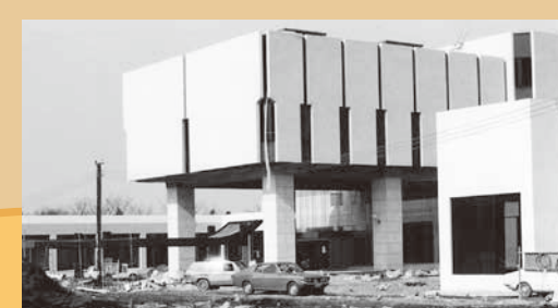
④役場新庁舎完成(昭和50年)
