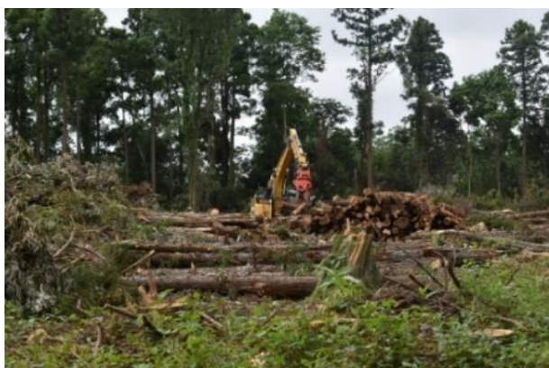
■市内の森林整備
