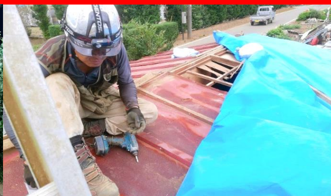
【屋根の補修・ブルーシート養生】
