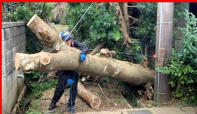
【敷地の倒木撤去作業】
