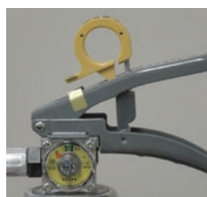
× 安全栓の抜けかけ
