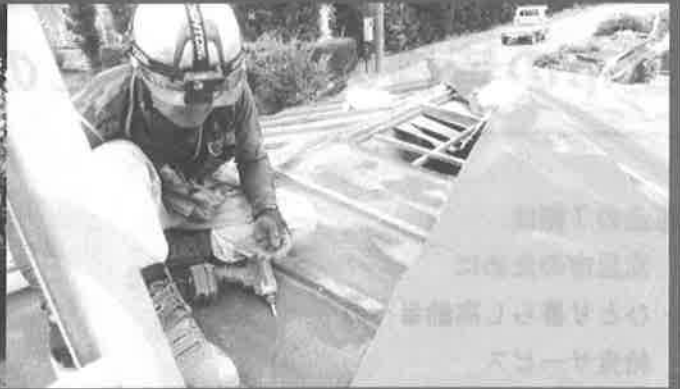
【屋根の補修・ブルーシート養生】
