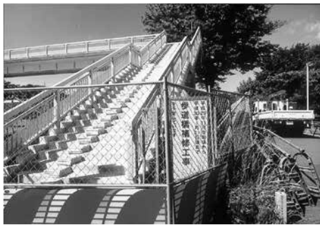
富里インター前歩道橋
