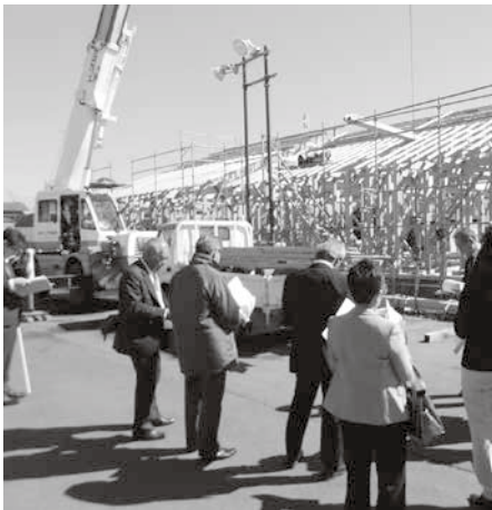
介護施設整備現地調査 (御料地先)
