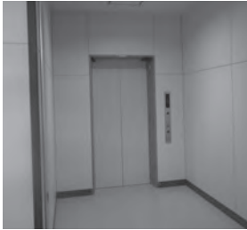
▲エレベーター設置工事が完了
