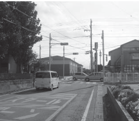
通学路安全対策として信号機設置に係る工事等を実施
