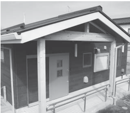
浩養小学校隣接地に学童クラブを新設
