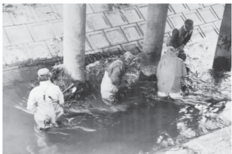
ごみの撤去作業（新橋地先）
