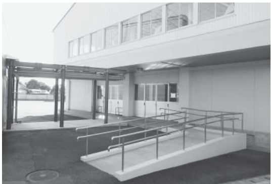
富里小学校・七栄小学校にスロープを設置 ※写真は浩養小学校
