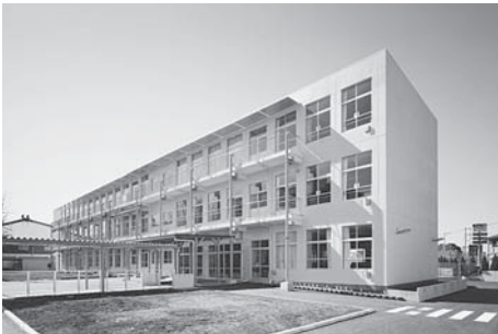
富小第二校舎耐震化完了
