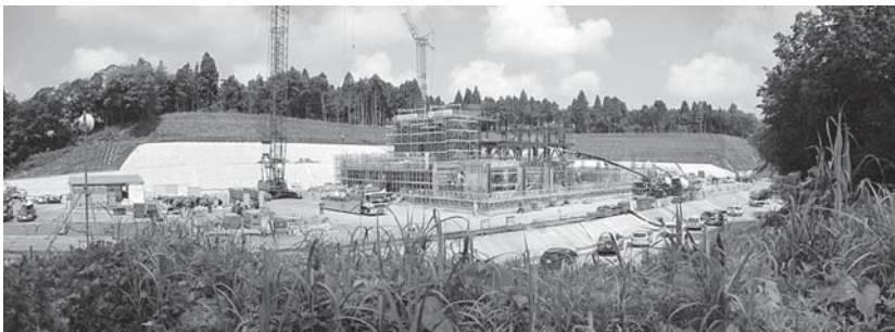
新清掃工場建設が進む
