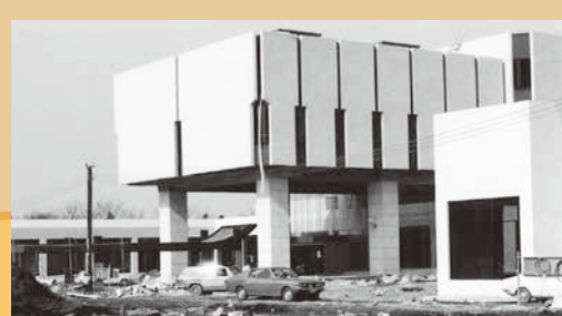
④役場新庁舎完成(昭和50年)
