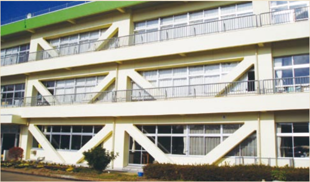
耐震化が完了した富里中学校校舎
