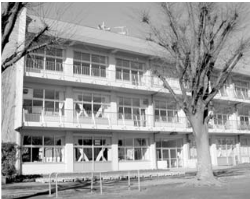
耐震補強された富里小学校
