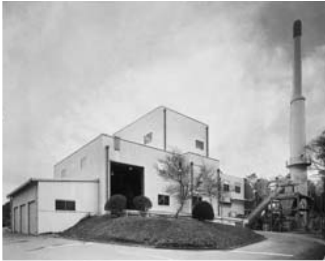
操業中止予定の清掃工場
