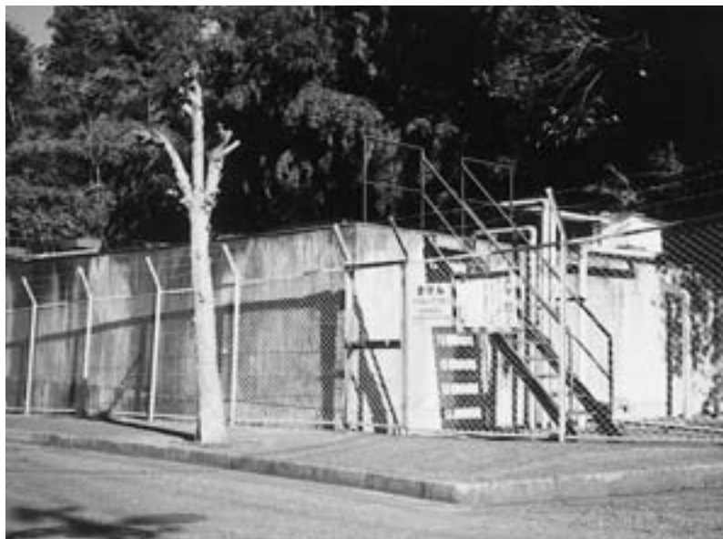
予算化された合併浄化槽修繕補助金
