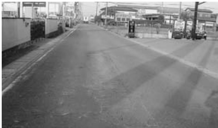
未整備の危険な道路
