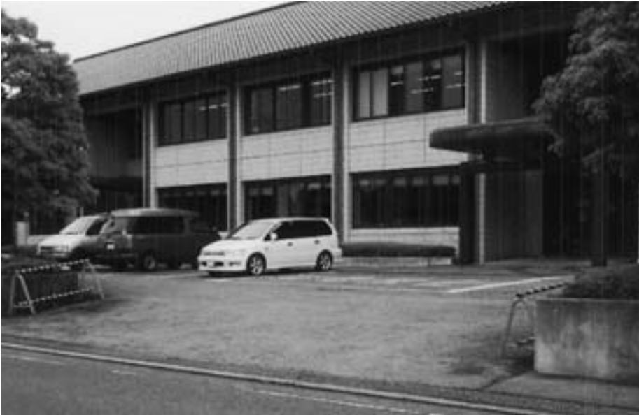
福祉センター（門扉設置）
