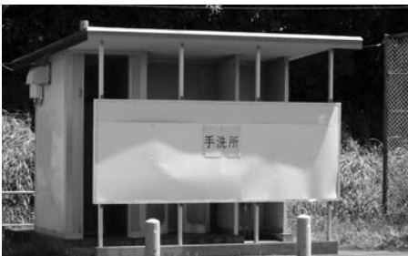
改修予定の十倉運動場トイレ
