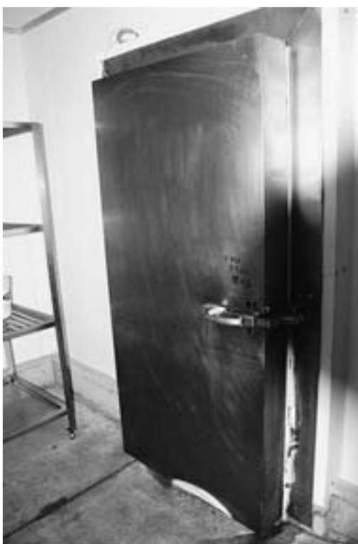
改修される第一調理場築造冷凍室扉
