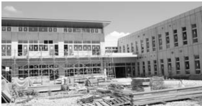
建設中の浩養小学校
