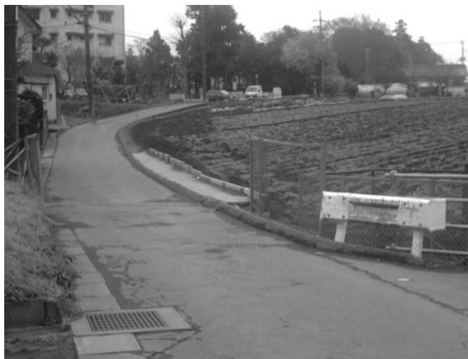
車がすれ違えない通学路
