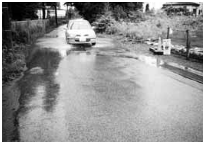
根木名地区市道の排水工事
