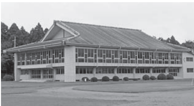
屋根と耐震補強設計予算可決（南小体育館）
