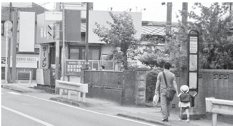
園児も利用する歩道の安全を（富里保育園前 国道296号線）
