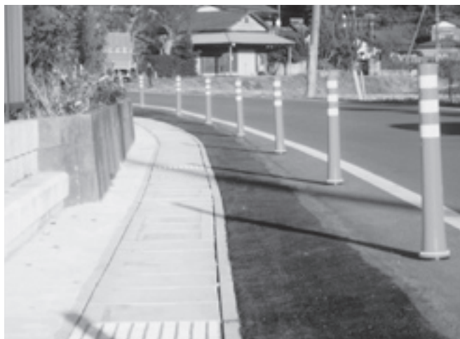
安全対策が進む008号線（新橋）
