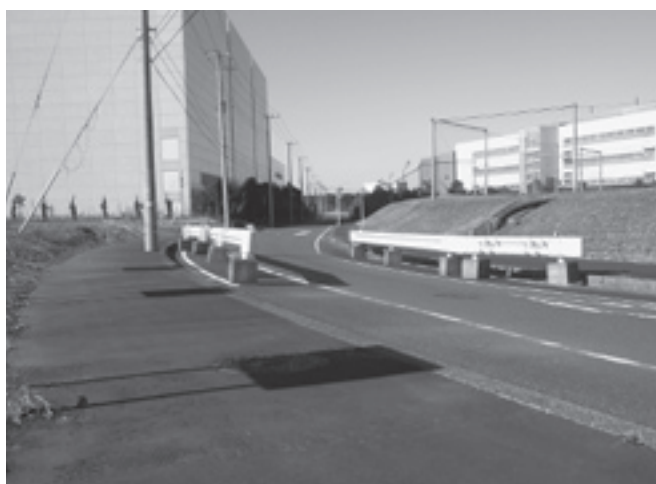
払い下げ予定の団地内道路
