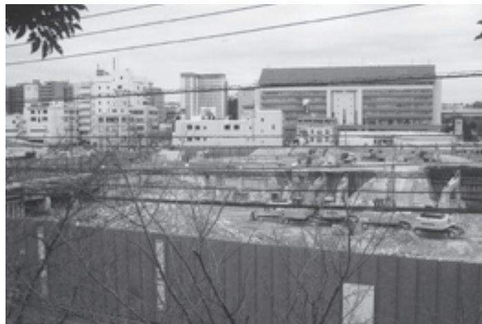
整地中の徳洲会病院建設地
