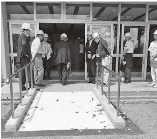
富里市立富里中学校バリアフリー化工事（スロープ・手摺り）所管事務調査
