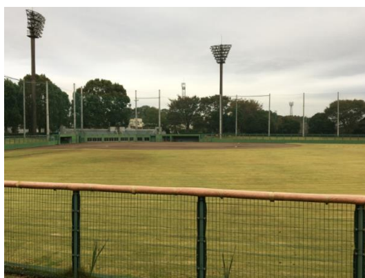
富里中央公園内、野球場の照明・フェンスなど
