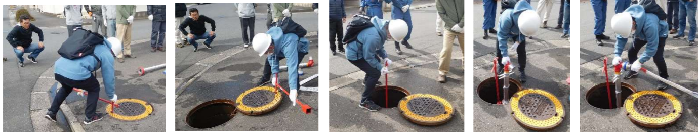
消火栓マンホールの蓋開けとスタンドパイプ取付け
