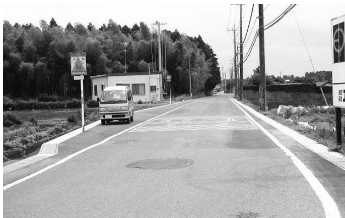
整備が進む 1-0188 号線付近
