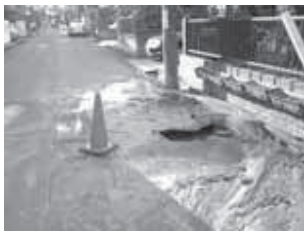
▶液状化現象により隆起した道路。このほかにも、市内各地の道路では、陥没や亀裂などが発生しました。
